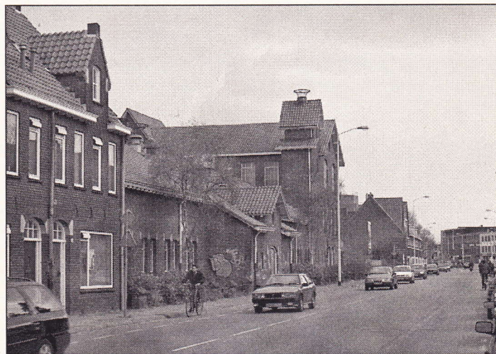
De huidige wand van de oude Catharinaschool aan de Mauritsstraat, inclusief het hoekpand op de Egmondstraat blijft behouden.
