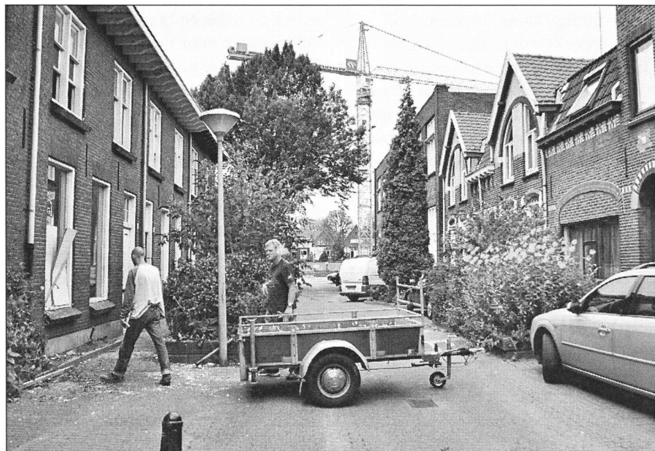
Overal in De Bergen wordt er gebouwd. Een nieuwe bewoner in de Oranjestraat is nog aan het slopen, achter hem in de Egmondstraat is onlangs de bouw van wooncomplex Cicogne gestart. Wethouder Schreurs verrichtte afgelopen donderdag de officiële opening.
